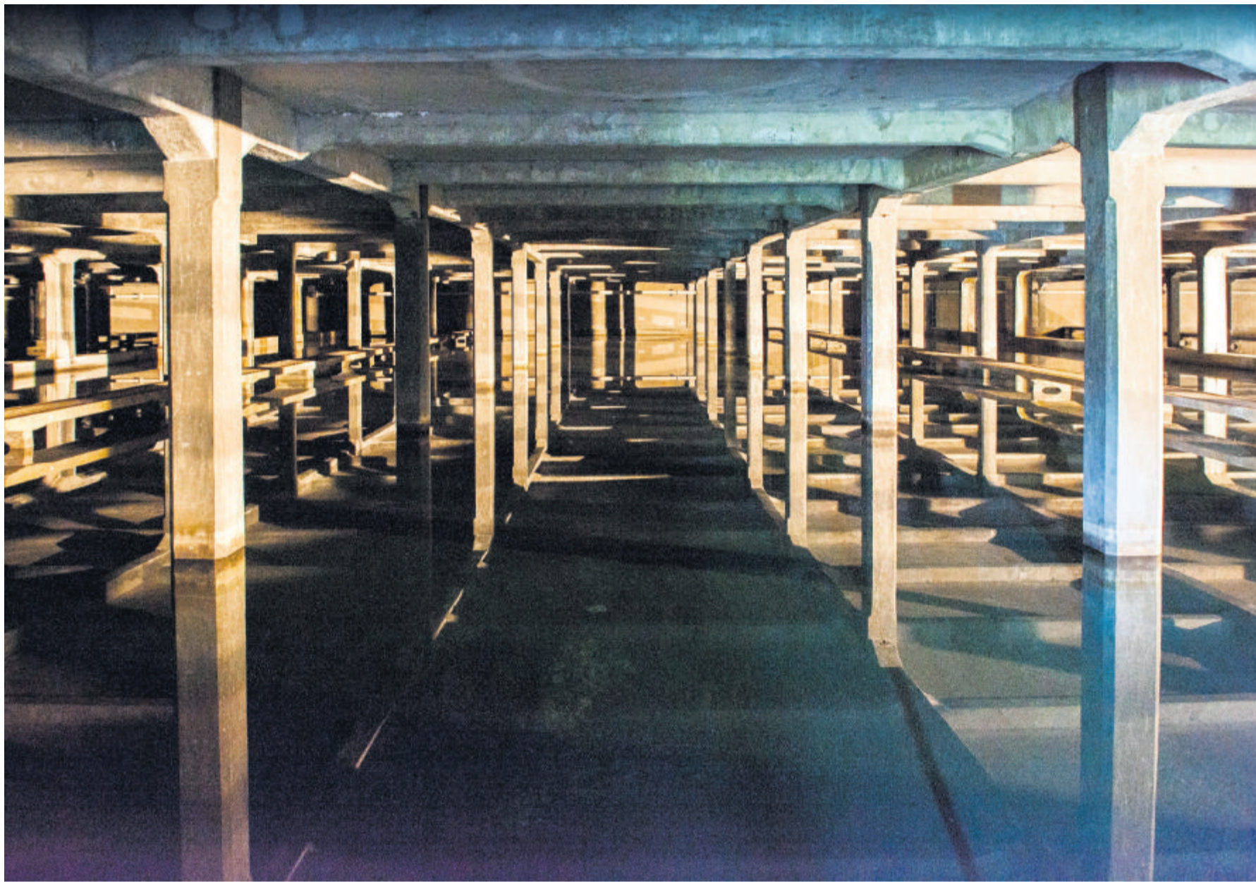
Wie heilige Hallen wirken die riesigen Langsamfilter der Anlage. Am Grund befindet sich Seesand, durch den das Wasser über Stunden strömt. Foto: Reto Oeschger
